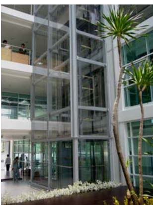
โครงสร้างปล่องลิฟต์ โครงเหล็กกรุกระจก
